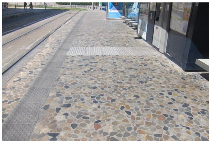
Figure 9 Exemple de bande d'interception en centre de quai à Montpellier
