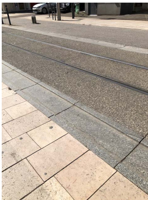
Figure 4 Bande de glo de Saint Etienne avec un dévers négatif de 15mm
