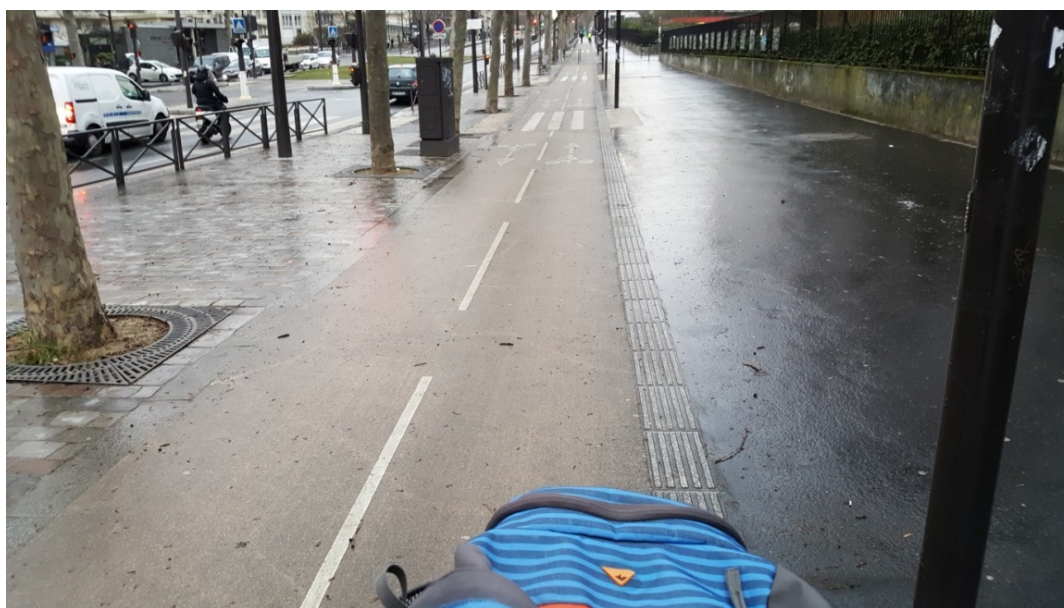
Figure 3 Mauvais usage de la bande de guidage pour séparer la piste cyclable du trottoir
