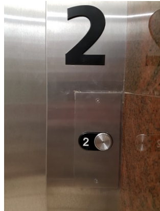
Figure 2 Bouton d'appel correctement situé
