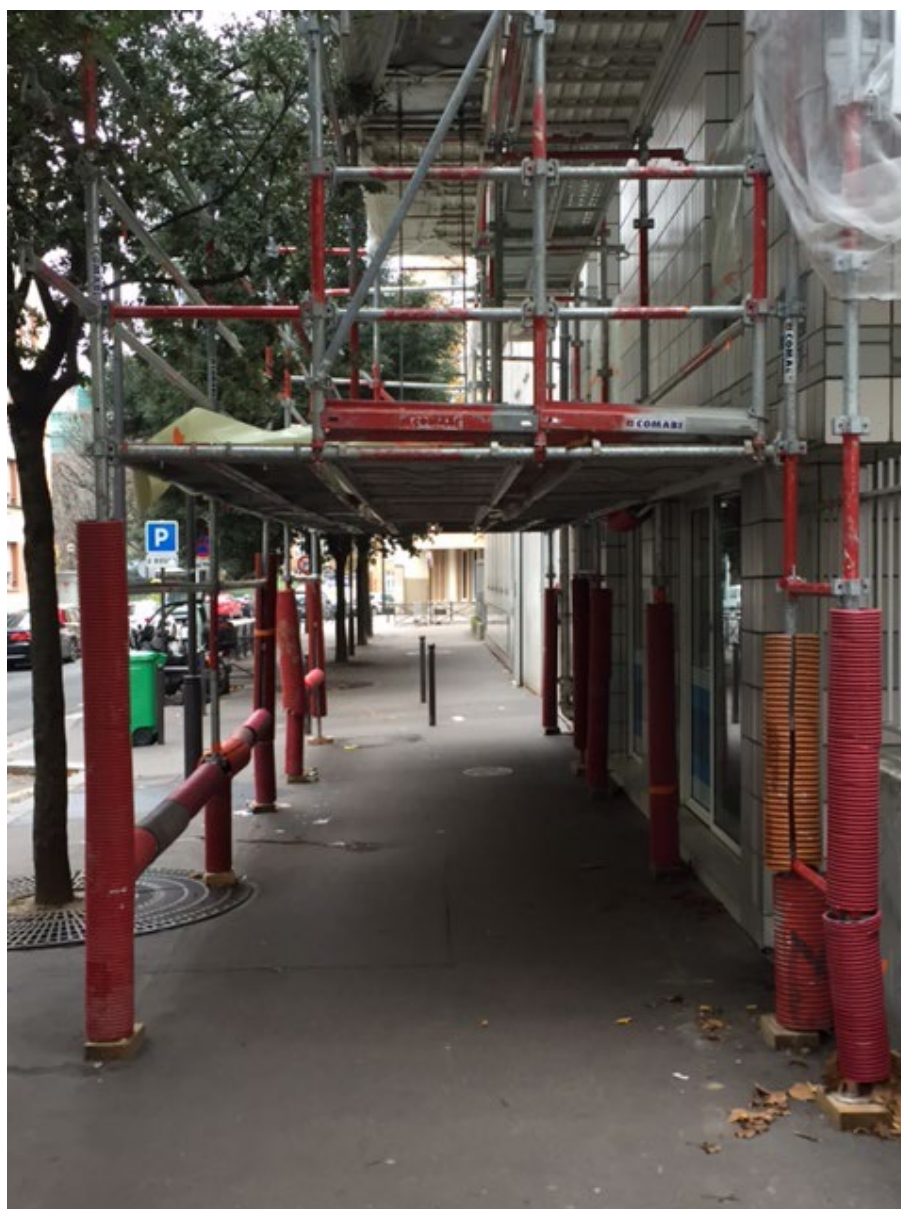
Figure 2 photo d'un échafaudage bien protégé
