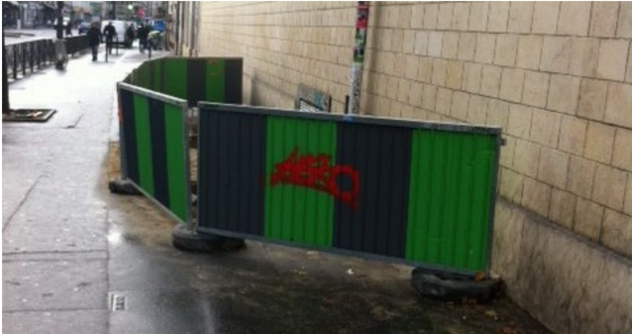
Figure 1 Protection de chantier sur trottoir
