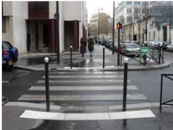
*Photo d'une traversée avec BEV et potelets bien implantés*
